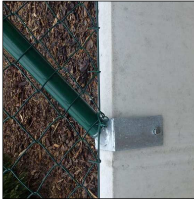
DRŽÁK K UCHYCENÍ VZPĚRY
