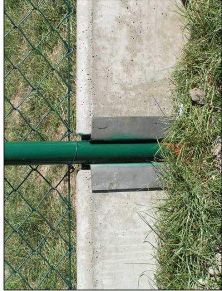
PODHRABOVÉ DESKY A JEJICH KOVENÍ KE SLOUPKŮM
